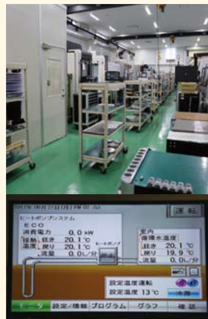
事務所スペースに設置されている地中熱ヒートポンプのコントロール画面
